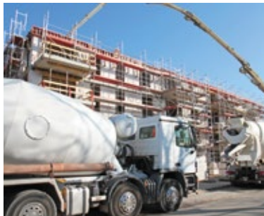
Bisher: Bauverzögerungen durch Wartezeiten für Deckenbetonagen
