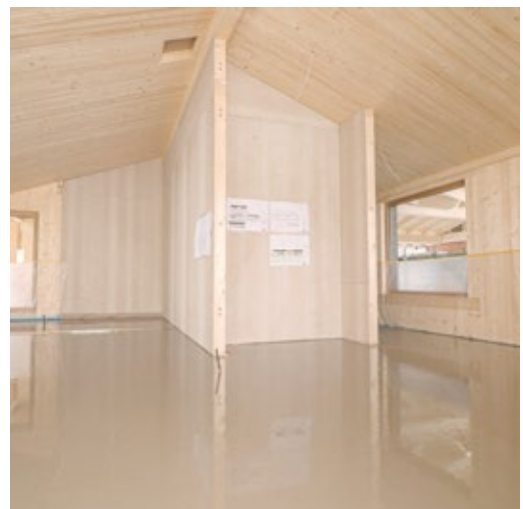
Und fertig ist die planebene Druckzone für den weiteren Estrichaufbau.
