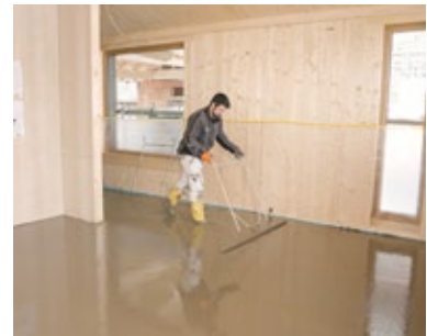
Neu: komfortabler Verguss „unter Dach“
