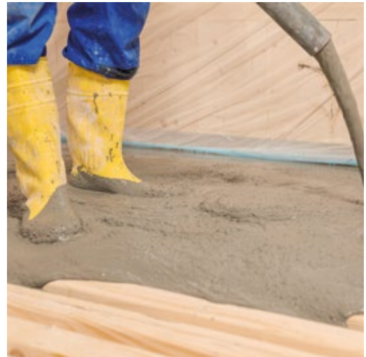
Einfaches Einbringen der maxit HBV Vergussmasse
