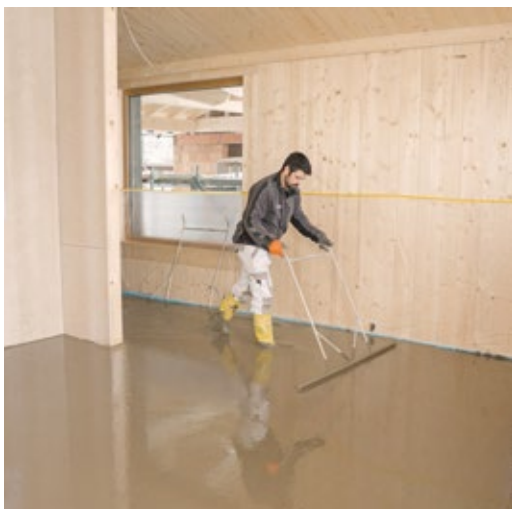
Schwabbeln – schafft eine ebenmäßige Oberfläche der maxit HBV Vergussmasse.
